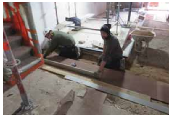
Pose des nouvelles marches devant l'Autel
