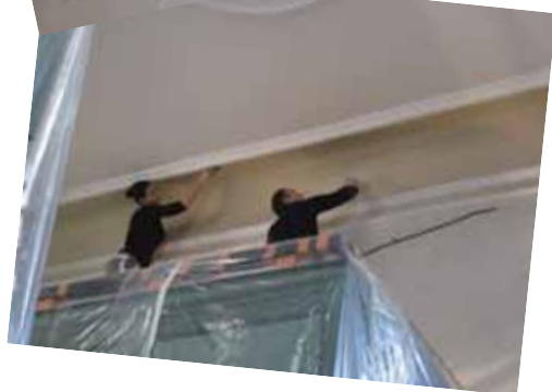
Ponçage des corniches
