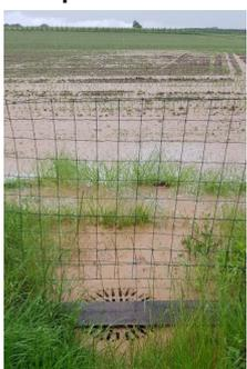
Exemple de solution privée, que la famille Rubin a réalisé après les déluges de mai et juin 2018. A gauche, en amont, collecte des eaux boueuses. A droite, en aval, évacuation par une canalisation enterrée de diam. 300mm longue de 35m et passant devant la maison.
